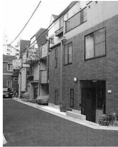
壁面が道路に迫り威圧感がある
